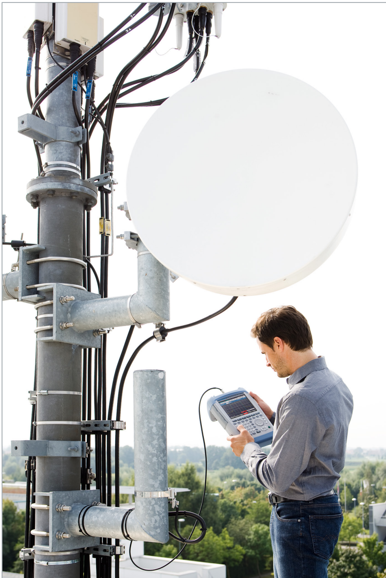
R&S®FSH im Einsatz bei der Installation und Wartung von Sendeanlagen
