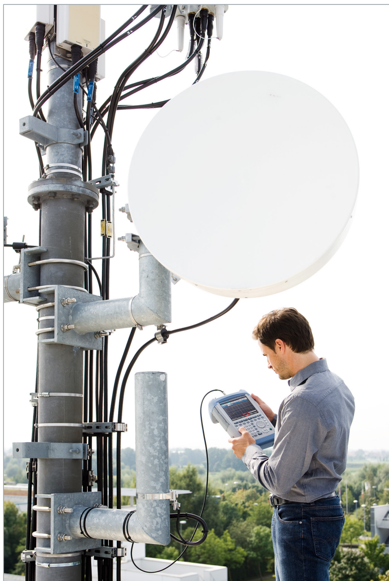
送信局の設置／保守中のR&S®FSH操作
